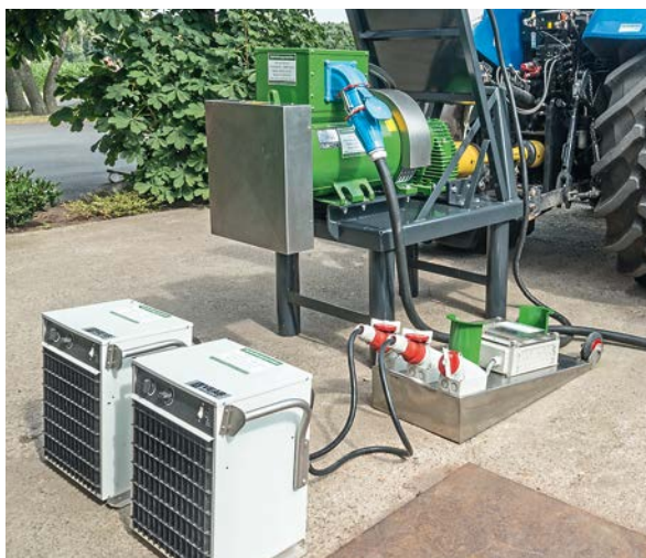
Mit zwei mitgebrachten, jeweils 30 kW starken Heizlüftern prüft die Firma immer als Erstes, ob Schlepper und Generator grundsätzlich miteinander harmonisieren.
