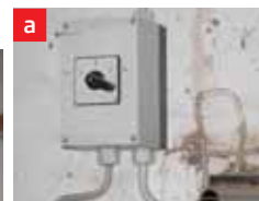
Der Einspeisepunkt (b) im Betriebsgebäude ist von der normalen Stromversorgung über einen Netztrennschalter (a) abgesichert.
