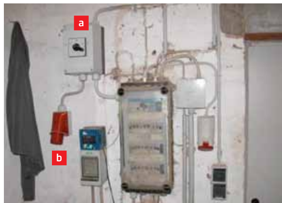
Der Einspeisepunkt (b) im Betriebsgebäude ist von der normalen Stromversorgung über einen Netztrennschalter (a) abgesichert.
