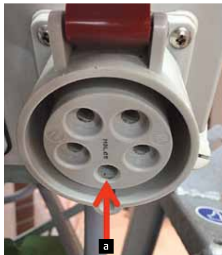
So unterscheiden sich die Steckdosen: normale Steckdose (a) mit Erdungsstift unten (siehe Pfeil); Steckdose (b) für die Hauseinspeisung mit Erdungsstift oben (siehe Pfeil).
