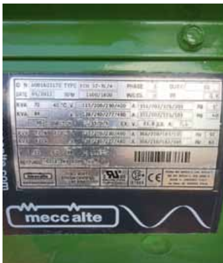
Das Typenschild eines Notstromaggregats gibt Auskunft über die wichtigsten Leistungsdaten.
